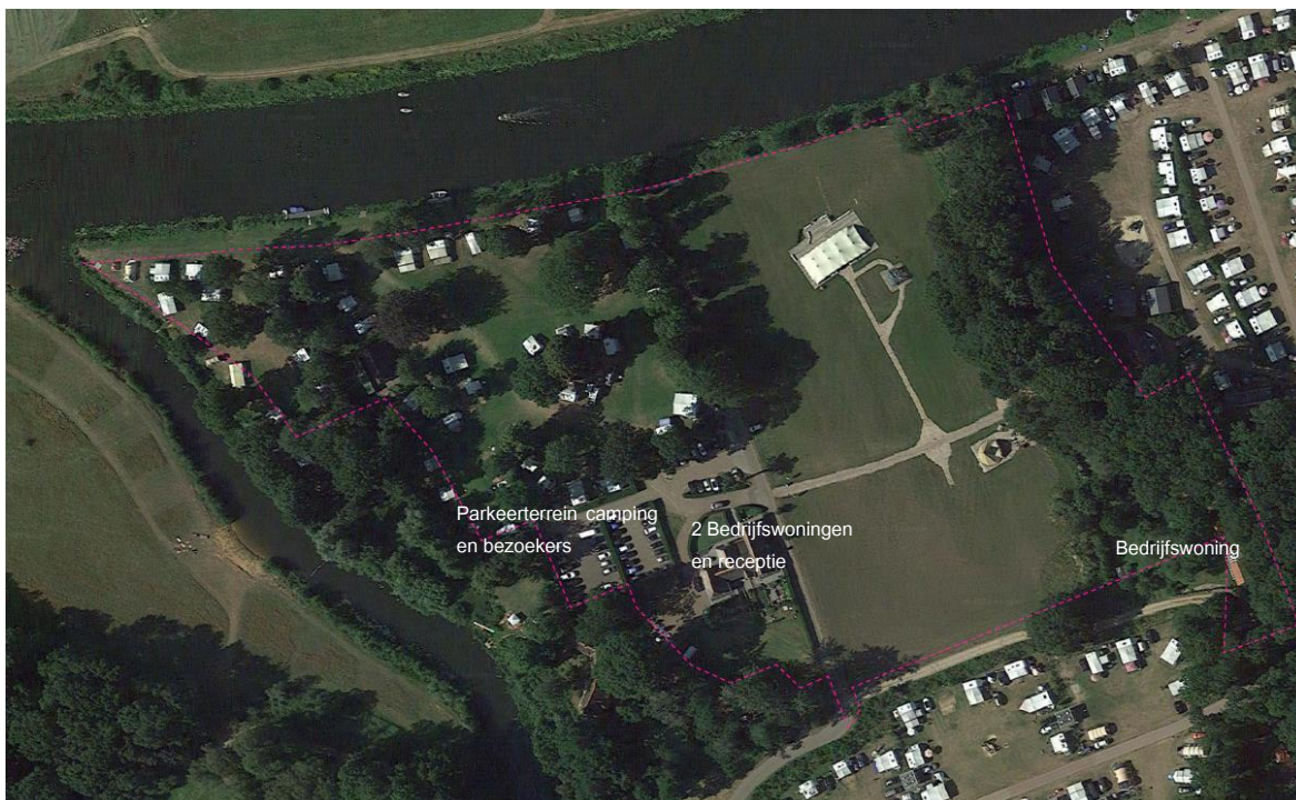
Afbeelding 4 Luchtfoto huidige situatie plangebied
