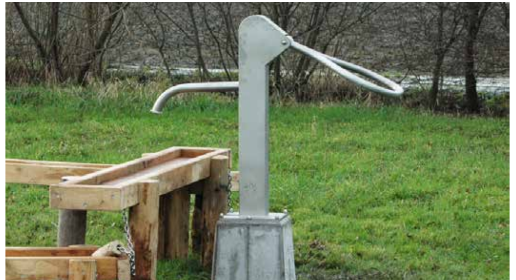
nieuwe pomp tijdens route
