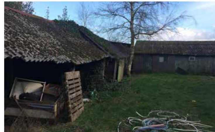
Afbeelding 10. Te slopen bijgebouwen
