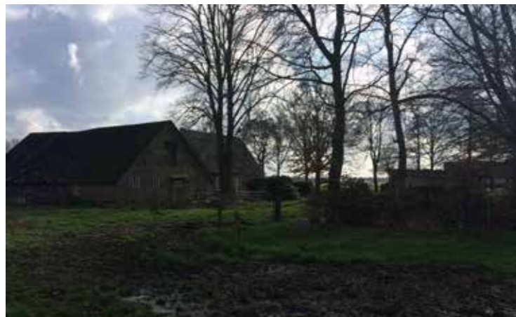
Afbeelding 11. Te slopen voormalige boerderij
