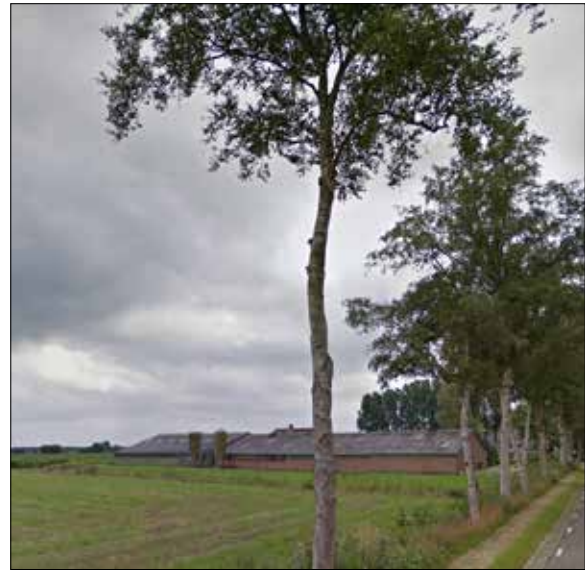
zicht op de te slopen stallen
