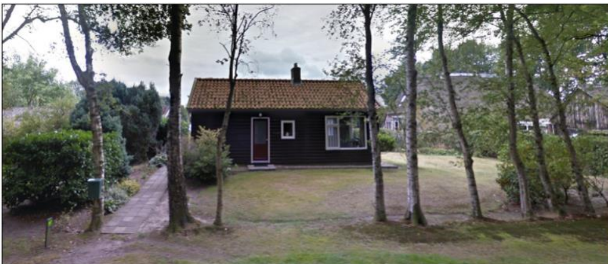
Afbeelding 2.3 Straatbeeld van de oude 'te verplaatsen' woning aan de Hessenweg West 14a (Bron: Google.streetview.nl)
