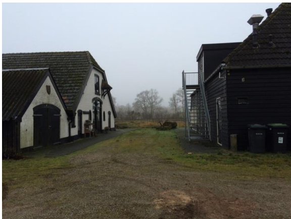
Figuur 7: Overzichtsfoto bebouwing
