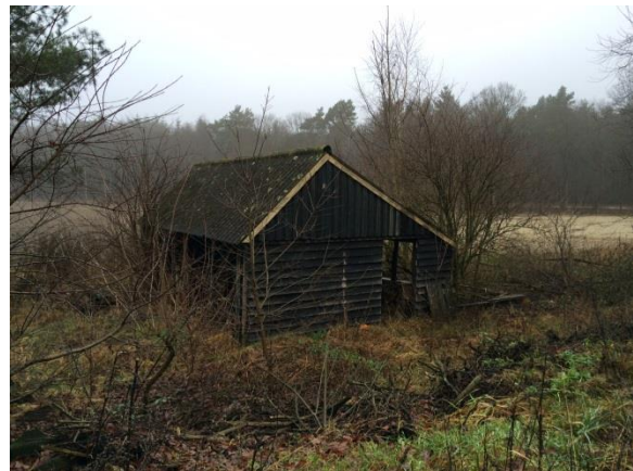
Figuur 8: Overzichtsfoto bebouwing
