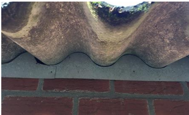
Door het afdichten van openingen kunnen grondgebonden zoogdieren (en vogels) niet onder de golflaten komen.
