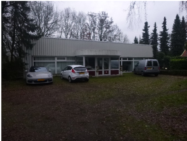
Meubelzaak aan de Witharenweg 4, westelijke zijde van het perceel
