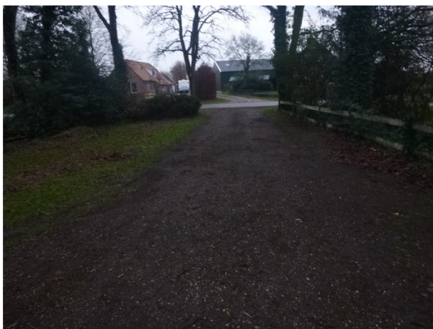
Grindverharding oprit meubelzaak, zuidelijke zijde van het perceel
