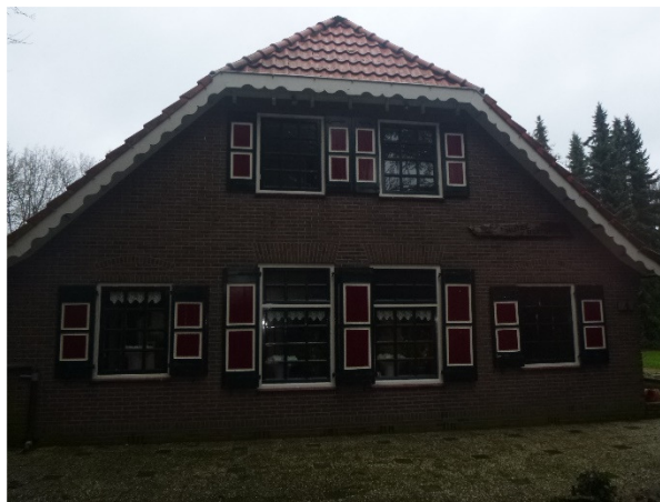
Woonboerderij aan de Witharenweg 4, zuidelijke zijde van het perceel
