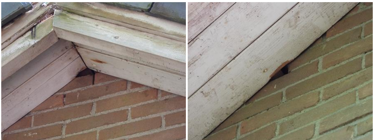
Openingen aan het gebouw welke mogelijk gebruikt worden als invliegopening voor vleermuizen.
