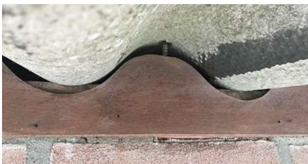
Afdichting onder de golfplaten; hierdoor kunnen steenmarters geen verblijfplaats bezetten onder de golfplaten.
