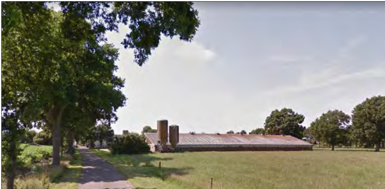
te slopen pluimveestallen
