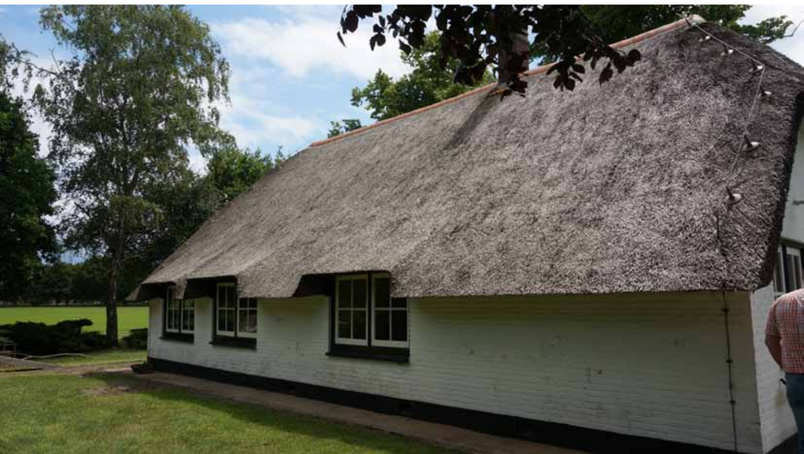
Afbeelding 8. De te slopen woning in het projectgebied
