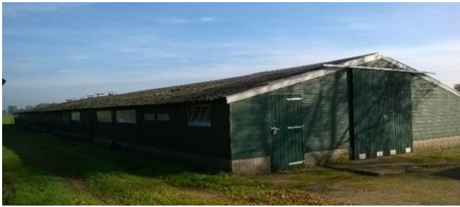
Figuur 2 Voormalig kippenschuur, nummer 1
