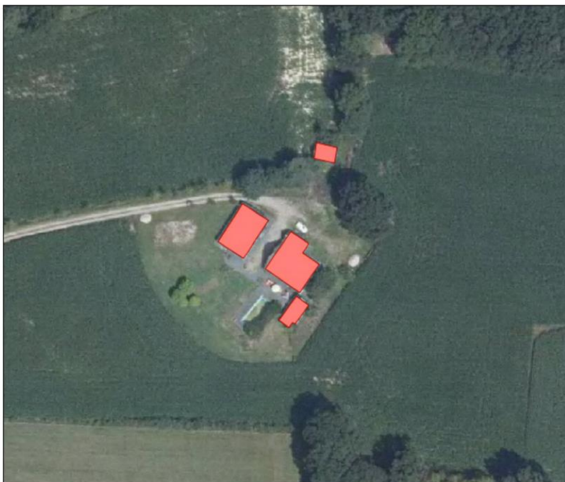
Afbeelding 2.4 Te slopen bebouwing (Bron ondergrond: provincie Overijssel)
