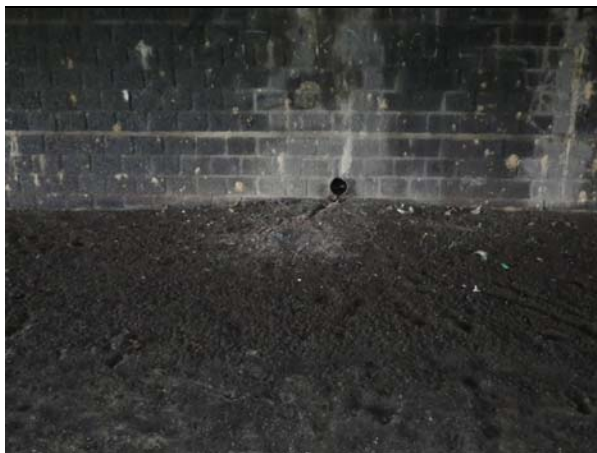
Figuur 4.1 Waargenomen leiding onder de brug
