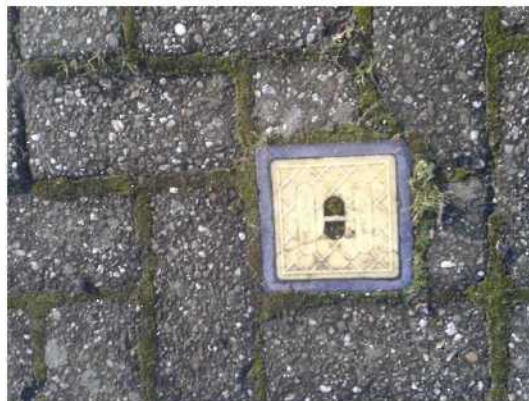
Afbeelding 2. Peilbuis verkenndend bodemonderzoek 2013
