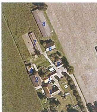
Figuur 3: De bebouwing Emslandweg 4
