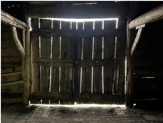
Houtconstructie en baanderdeuren
