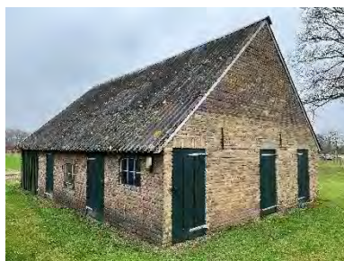
De oost- en zuidgevel (zijgevel)
