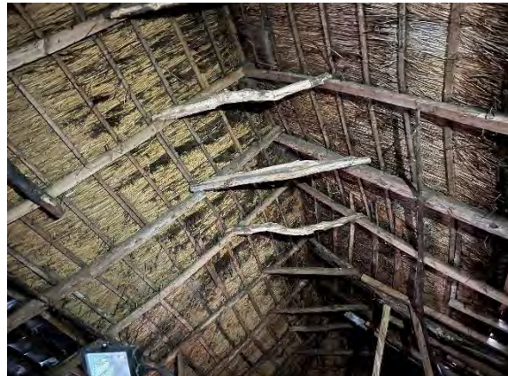
Kapconstructie van de schuur
