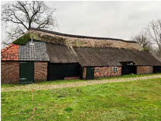
Achtergevel van de schuur
