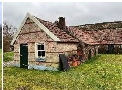
De voor- en zijgevel (zuid-west)
