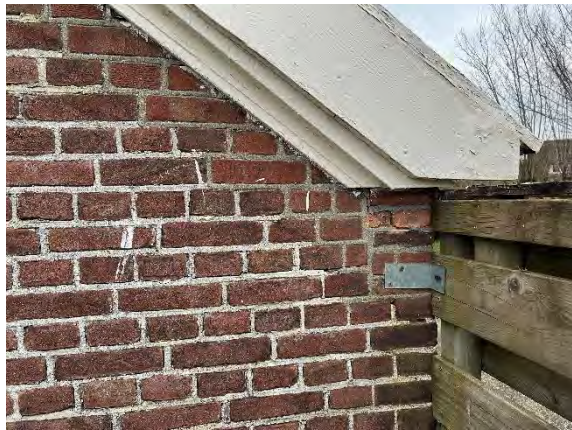
Detail metselwerk verhoging van de gevel
