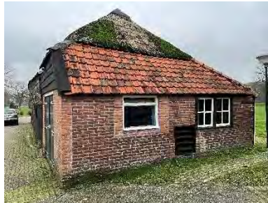
Rechter zijgevel (tanklokaal)
