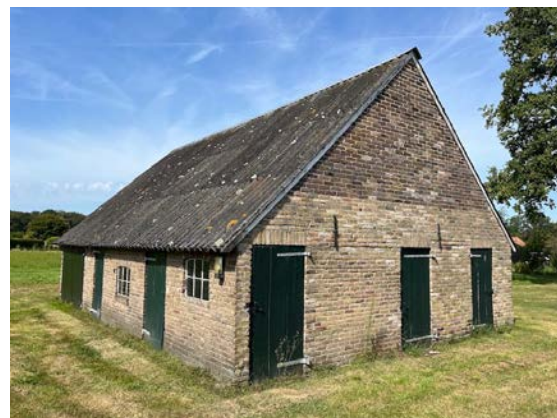
Figuur 8. Kleine schuur (gebouw 4).
