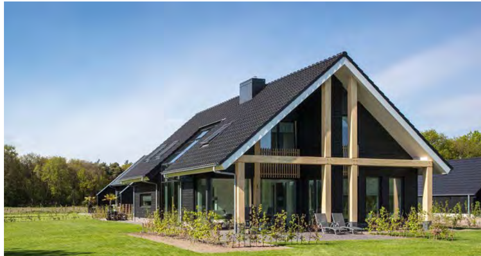
Verbijzonderingen in het volume gaan niet ten koste van de heldere hoofdvorm, de buitenruimte is daarbij geïntegreerd in het volume
