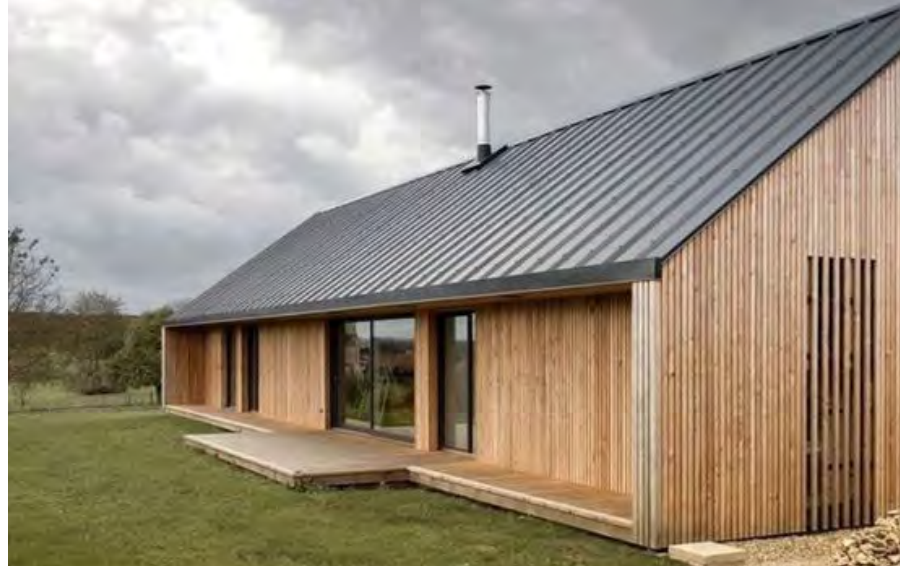
Eenvoudige hoofdvolumes, verfijning zit hem in de details zoals een verholen goot, HWA weggewerkt achter gevelbetimmering
