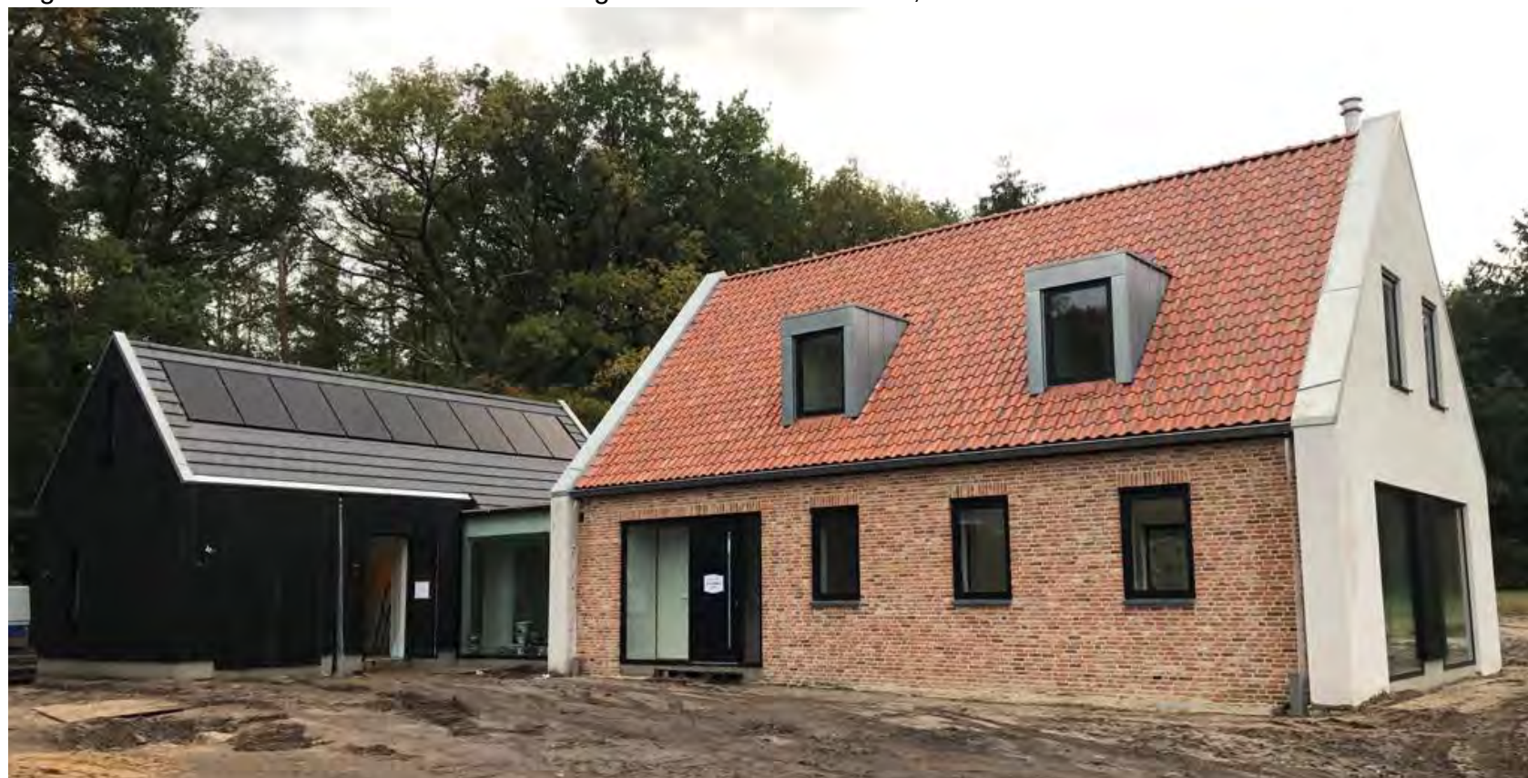
Zonnepanelen zijn bij deze rode pan mooi opgelost op het bijgebouw. De zijgevel van metselwerk past goed aan de Varsenerweg maar de witte pleisterwerkgevel is te dominant aanwezig en niet toegestaan op deze plek.
