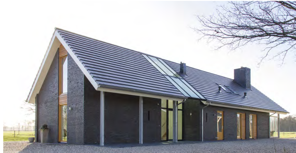
Baksteen, hout en zink vormen de basismateriaal
