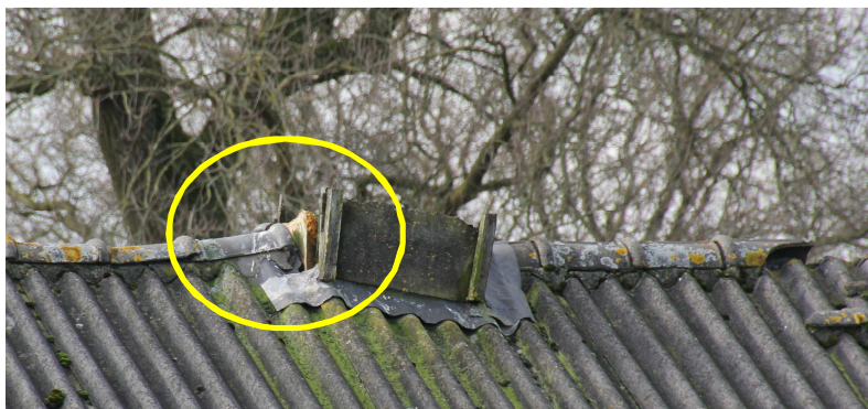
Mogelijke schijfsporen van een Steenuil op het dak van een schuur in het onderzoeksgebied.
