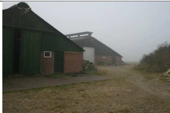
Te slopen bedrijfsopstallen
