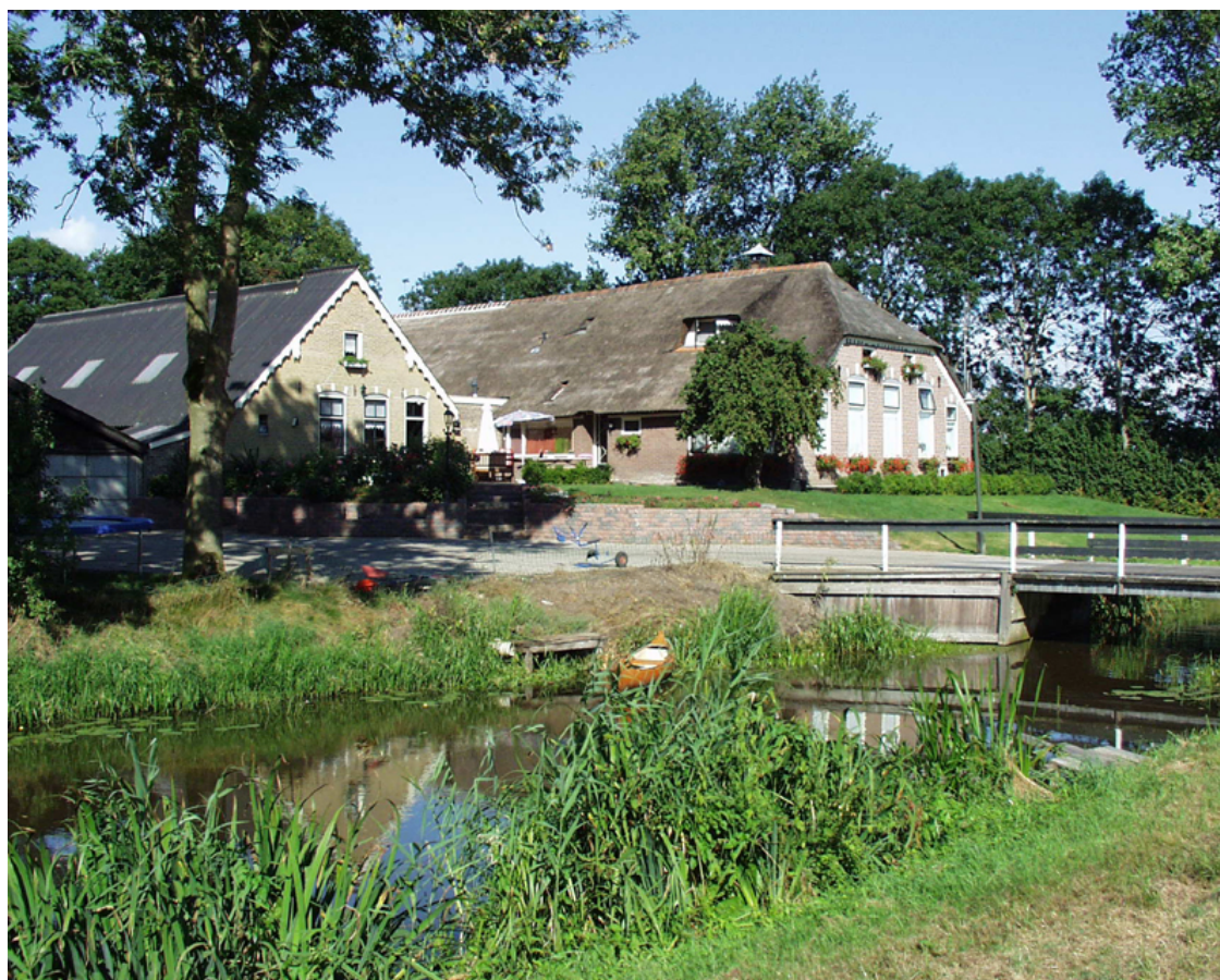
Brug als toegang naar het erf
