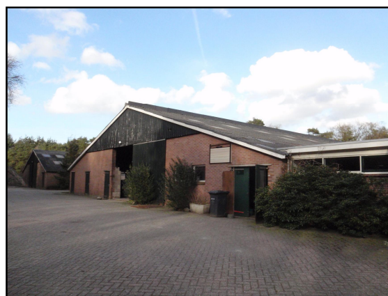
Foto 3 en 4. De te slopen stallen (boven en onder).
