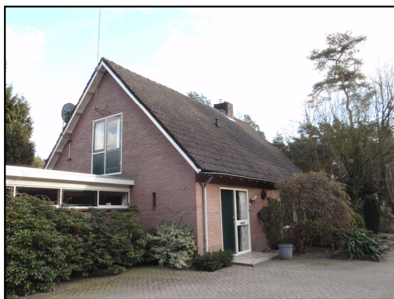
Foto 1 en 2. De te slopen stal (boven) en de te behouden woning (onder).
