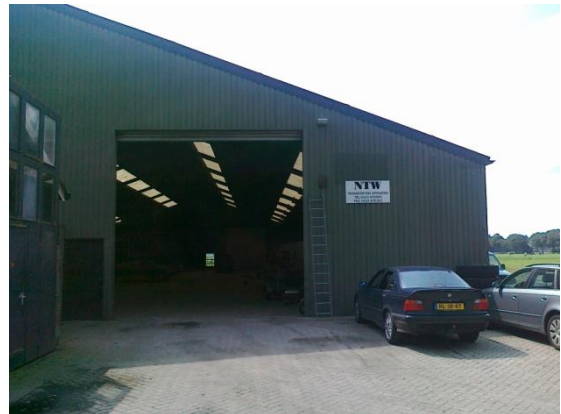
Afbeelding 3: de aanwezige opslagloods.
