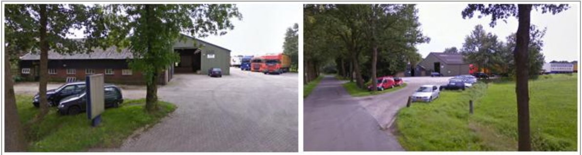
Afbeelding 2.3 Aanzichten van het erf aan de Woestendijk 1-2 (bron: Google streetview)
