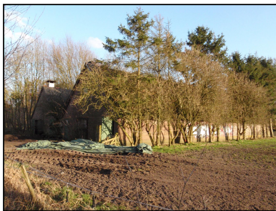
Foto 3 en 4. De te slopen stallen.
