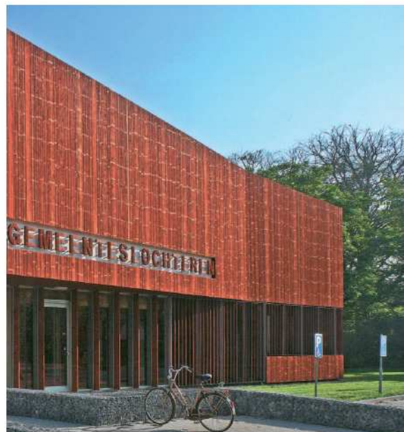
verticale geleding, aardse kleuren, reclame mee ontworpen
