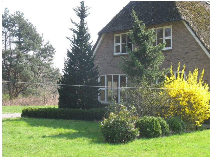
Figuur 1: De voorgevel van de bestaande pachtboerderij.
