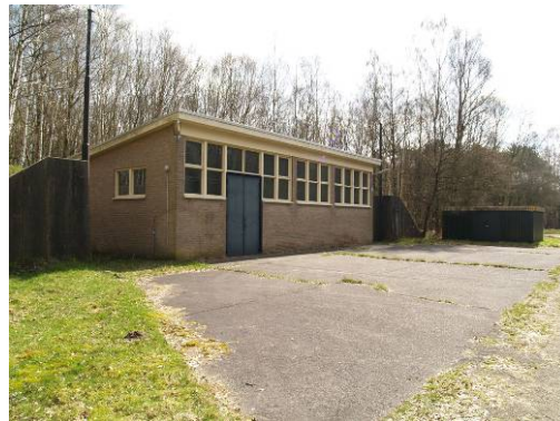
Gebouw H en omliggende bemuring
