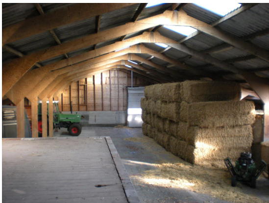
Foto 6: te slopen schuur
