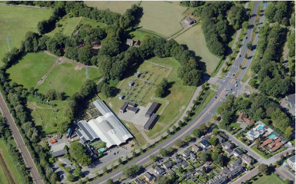
Ligging hoogspanningsstation Oldenzaal
