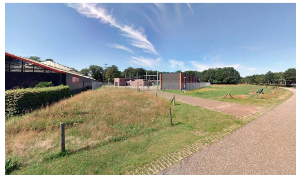
Entree hoogspanningsstation Oldenzaal via de Inslagstraat
