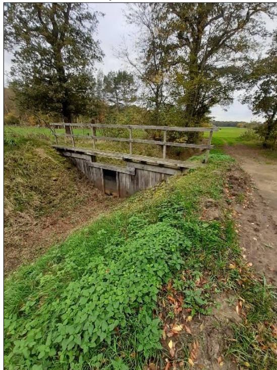
Foto 22: Stuw zuidzijde (d.d. 03 november 2020)
