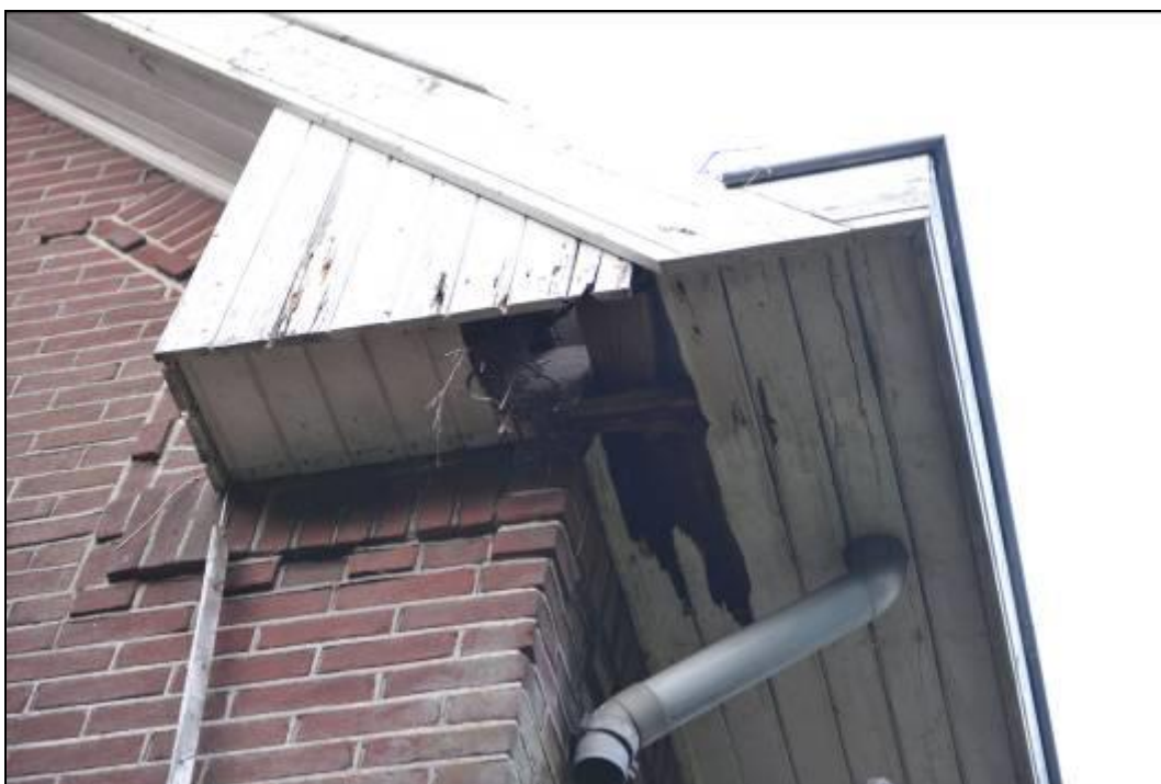
Figuur 4.3-2: Voor huismussen toegankelijke dakranden in de boerderij.
