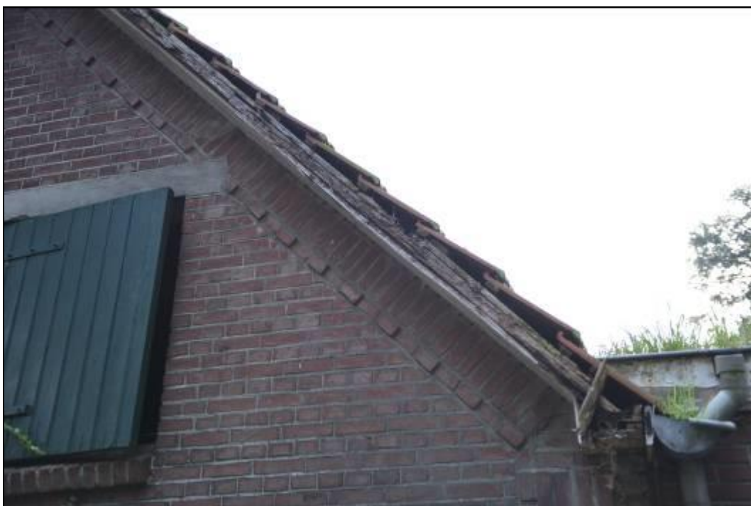
Figuur 4.3-1: Voor huismussen toegankelijke dakranden in de boerderij.
