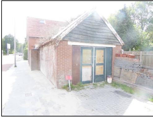
Schuur met golfplaten dak
