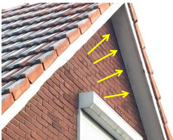
Aanduiding van de opening die vleermuizen de kans biedt een verblijfplaats te bezetten in de spouw van de woning.
