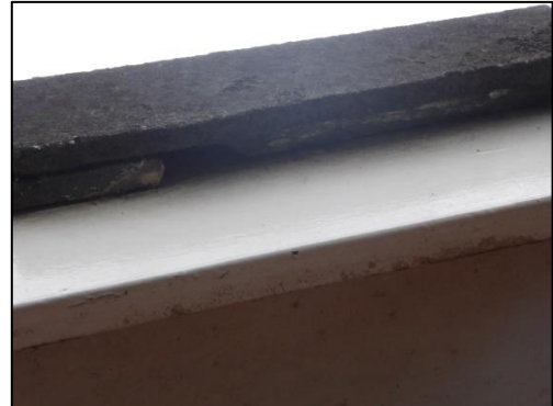
Ruimte achter dakpan.
