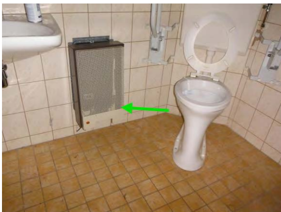
Foto 3: Pakking, afdichting kachel M2
