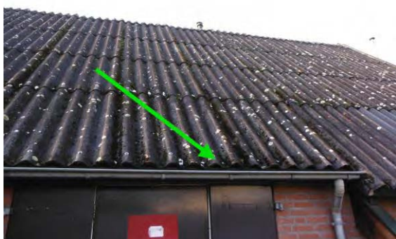
Foto 9: Golflaat incl. vormstukken, dakbedekking M5
