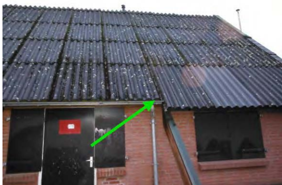
Foto 7: Golflaat incl. vormstukken, dakbedekking M4
