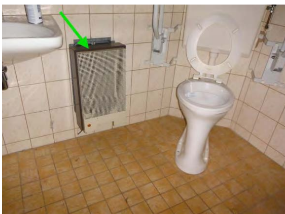
Foto 5: Koord, afdichting M3
