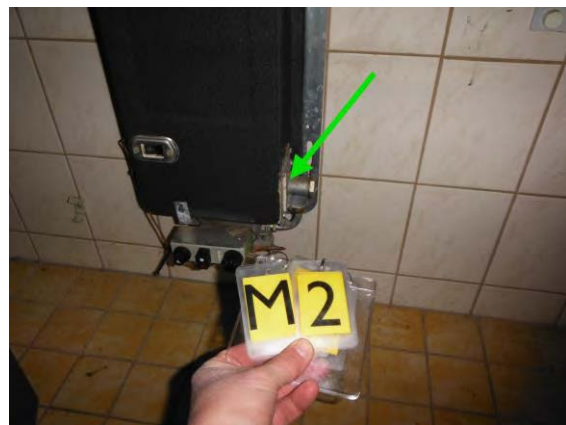
Foto 4: Pakking, afdichting kachel M2
