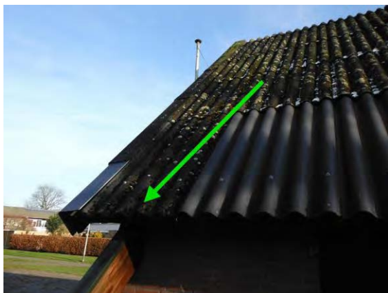
Foto 11: Golflaat incl. vormstukken, dakbedekking M6
