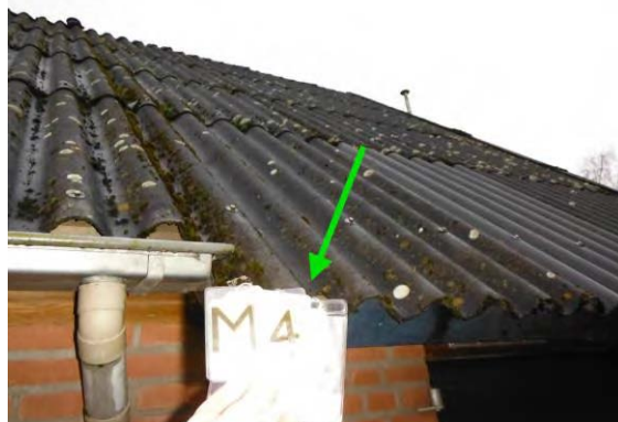
Foto 8: Golflaat incl. vormstukken, dakbedekking M4
