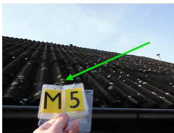
Foto 10: Golflaat incl. vormstukken, dakbedekking M5
