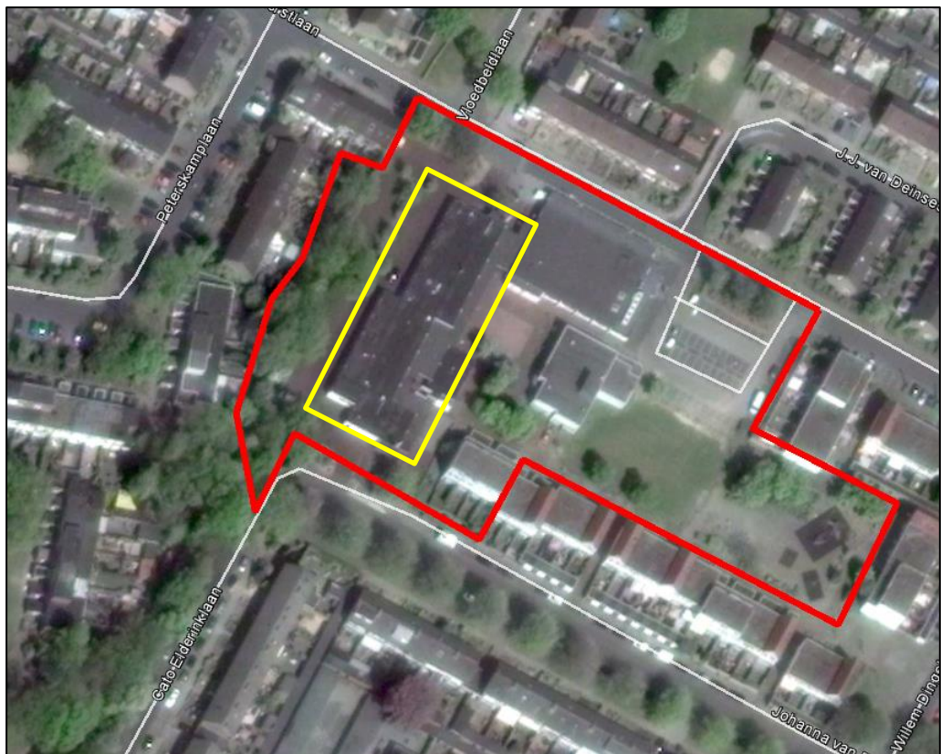
Voorbeelden van open stootvoegen in bebouwing in het plangebied. En een luchtfoto van het plangebied waarin met een gele omkadering is aangegeven welke panden mogelijk vleermuisverblijfplaatsen bevatten.
