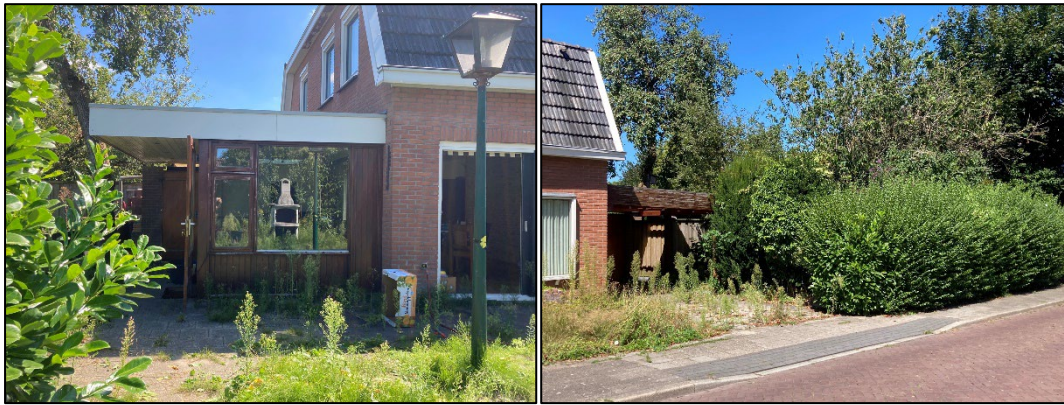
Figuur 2.11 (links): Het deel van het woonhuis dat wordt gesloopt bestaat uit een aanbouw; Figuur 2.12 (rechts): De tuin gezien vanaf de Gruttostraat.
