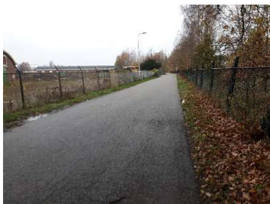
Parallelweg in vanaf oostelijke punt westelijke richting
