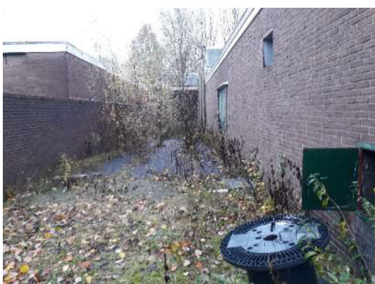
Oostzijde zuidelijke bebouwing (laadkuil en asfaltverharding)
