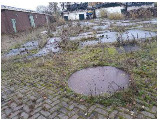
Voorterrein met put en vml betonvloer
