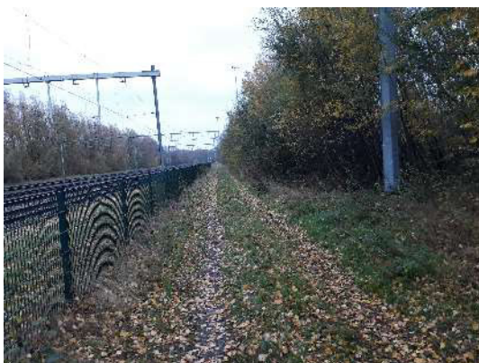
Strook langs het spoor (in oostelijke richting)
