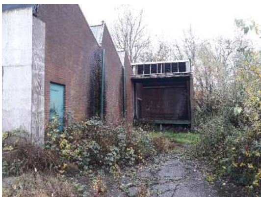
Laadperron westzijde zuidelijke bebouwing (asfaltverharding)
