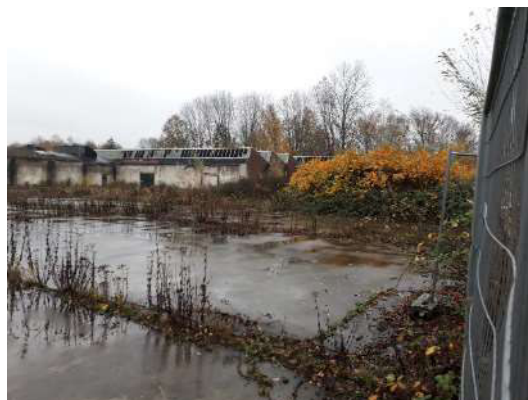
betonverharding en bebouwing zuidzijde
