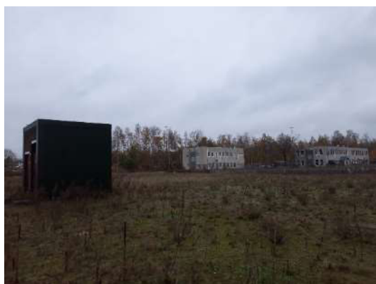
in noordelijke richting vanaf Helmhichstr 35, Trafogebouw
