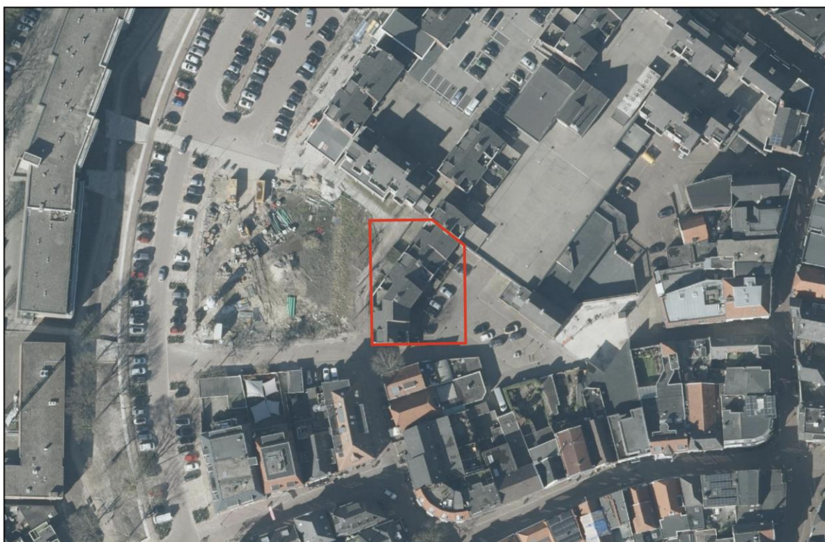
Afbeelding 2.1 Luchtfoto huidige situatie plangebied (Bron: PDOK)
