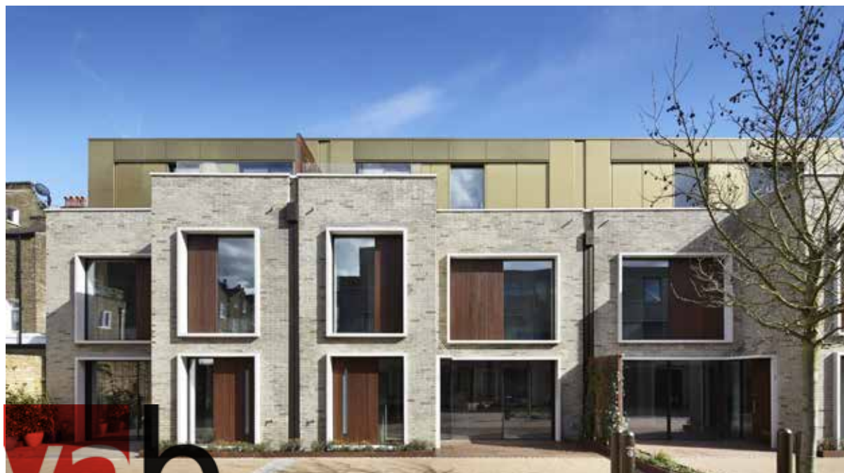
Betonnen detail rondom kozijnen
