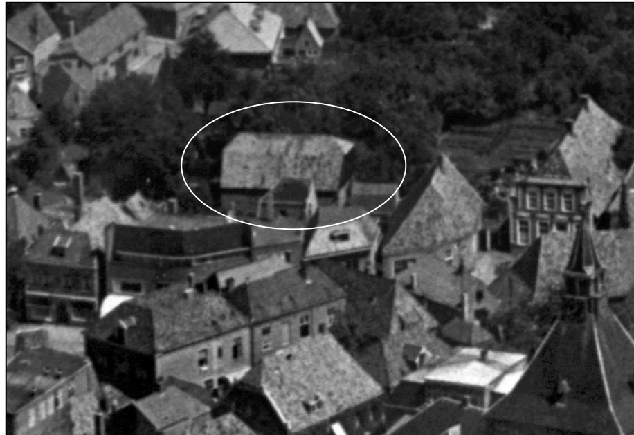
Afbeelding 7 – uitsnede van een historische luchtfoto uit 1946, met zicht op het magazijn. op de foto is de oorspronkelijke kapvorm goed te zien: een mansardekap met afgewolfde uiteinden.
