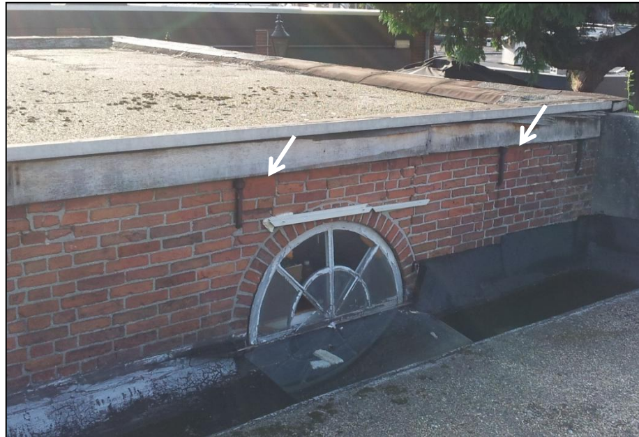
Afbeelding 9 – noordelijke hoek van de oostelijke langsgevel. Het bouwwerk steekt circa 1,2-1,5 meter boven de omringende bebouwing uit. Het metselwerk is betrekkelijk slordig en functioneel opgezet. Te zien is dat de maatvoering van de metselaar niet klopt. Op meerdere plekken zijn passtukken gebruikt om uit te komen. Rechts naast de ankers zijn dichtzettingen te zien in baksteen op zijn kant. Deze dichtzettingen zijn met een pijl aangegeven. In het gevelmetselwerk ontbreken diverse ankers.
