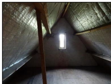
Figuur 7. Zolder van gebouw 2 met isolatie tegen het dakbeschoot.
