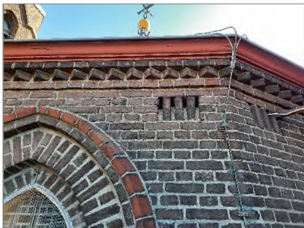
Figuur 5.2: Stavenventilatie roosters die een potentiële verblijfplaats voor vleermuizen vormen.
