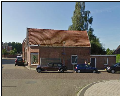
Aanzicht voormalige bebouwing in het plangebied
