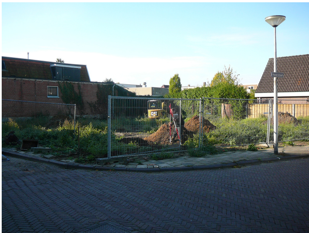
Foto 1: locatie vanaf het noordoosten gezien
