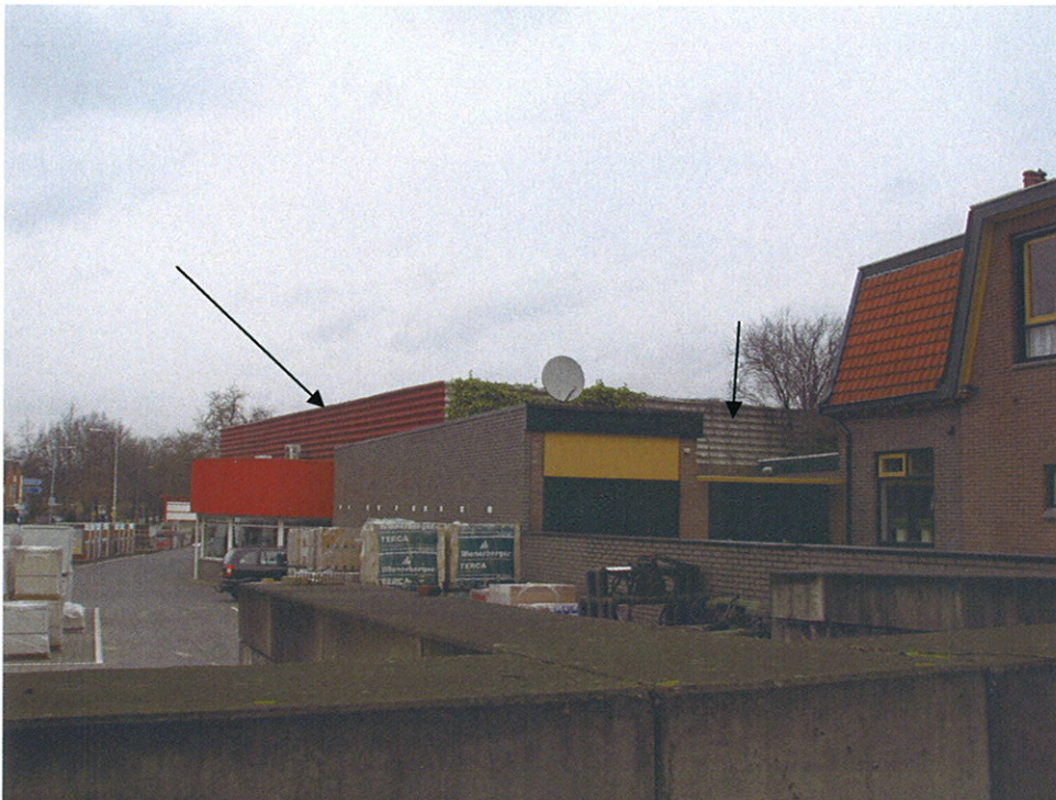
Foto 1: de golfplaten als boeien en op het dak (Abm/001)
