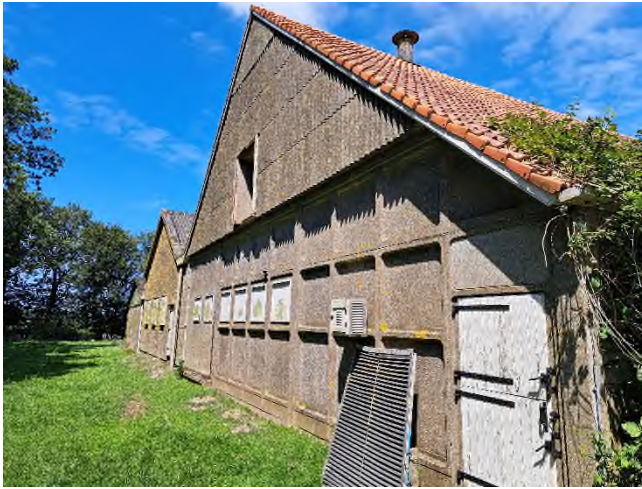
Figuur 3.16: Achterzijde schuren.
