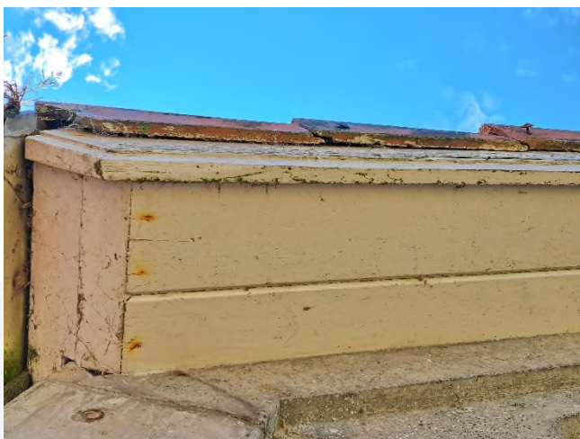
Figuur 3.12: Ruimten tussen en onder kantpannen eerste schuur.
