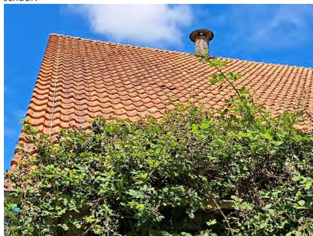
Figuur 3.13: Dakpannen dak eerste schuur.
