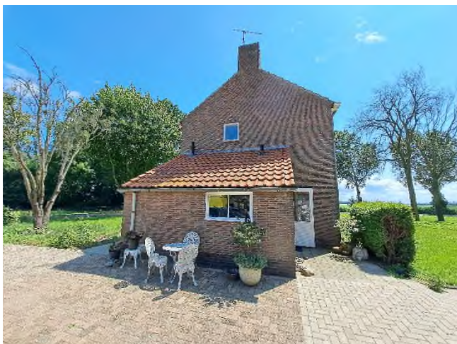
Figuur 3.4: Noordzijde woning.
